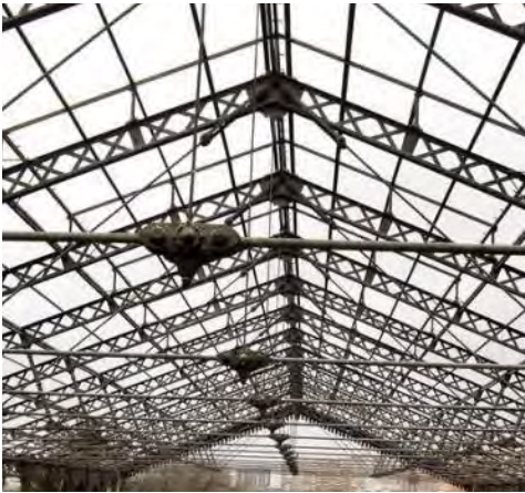
Estado en el que se encontraba la cubierta antes de la remodelación final para convertirla en la Casa del Mediterráneo.
