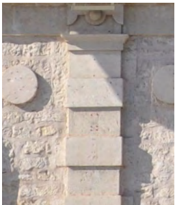
Los interpaños se separan con pilastras sobre un zócalo. Las pilastras llevan basa, fuste y capitel
