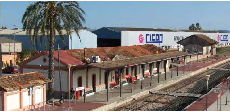
⬇ Fue inaugurada en 1884, la construyó la Compañía de Ferrocarriles Andaluces.
