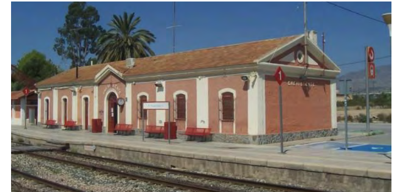
La estación de Crevillente.
