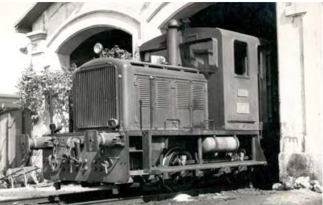
⬆ Locomotora saliendo del andén de la antigua estación. (Foto Luis Berenguer)
