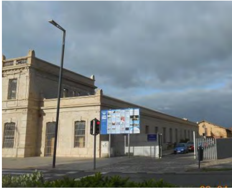
⤴ Aparcamiento para coches, año 2021.
