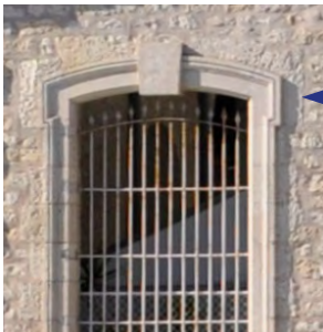
Los vanos de los extremos son de arco escarzano con claves y cuarterones resaltados.
