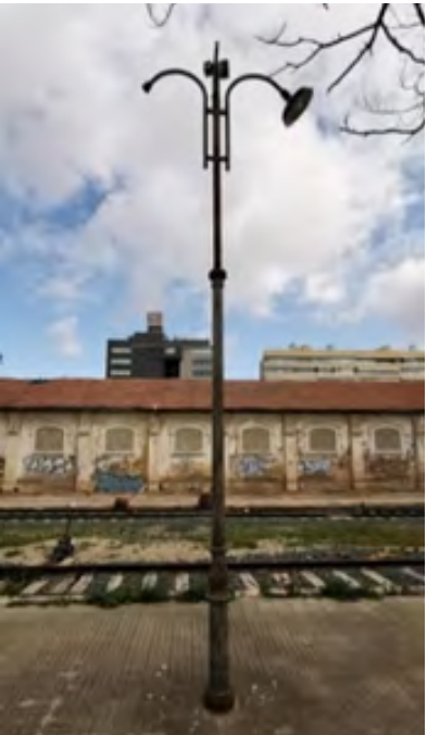
Focos para iluminar las vías y los andenes.
