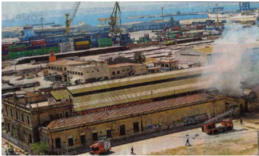
Incluso ha sufrido varios incendios al estar en estado de completo abandono. Como el tercero en un año, ocurrido el 5 de abril del 2008.
