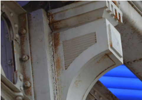
Todo el extremo lateral, está rematado por un canalón recubierto inicialmente con una estructura de cinc y que incluye una decoración de remates muy atractiva.
