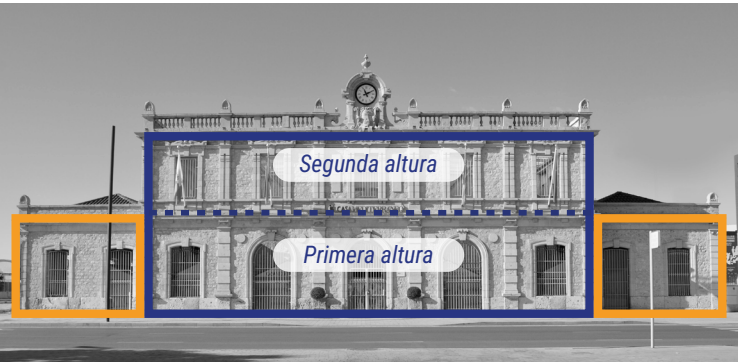
La división de la fachada en bloques: en azul el bloque central y en amarillo los bloques laterales
