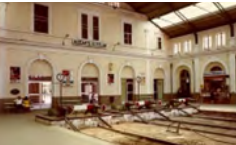
Toperas en su emplazamiento original
