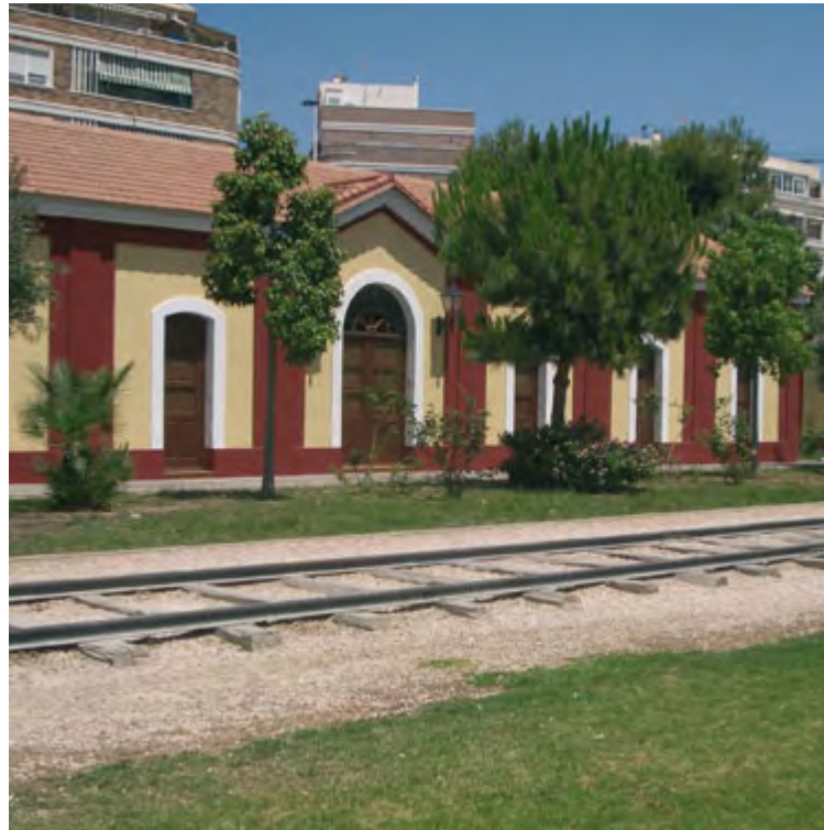
Estación de Torre Vieja restaurada.
