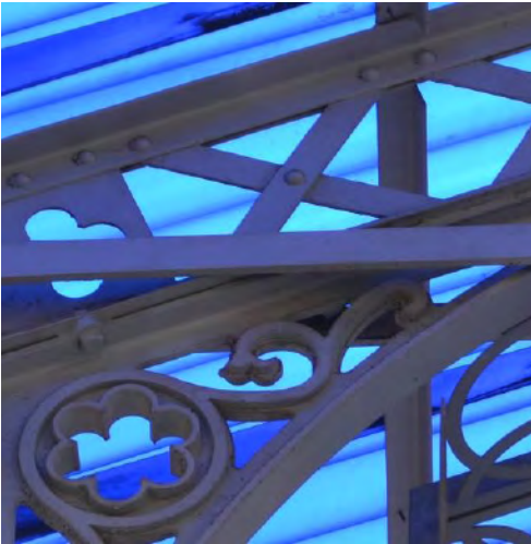
Detalles de las nuevas formas de decoración en donde se utilizan los remaches, los tornillos y herrajes como elementos estéticos.
